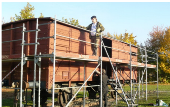
Siggie Hubele bei Arbeiten am Waggon
